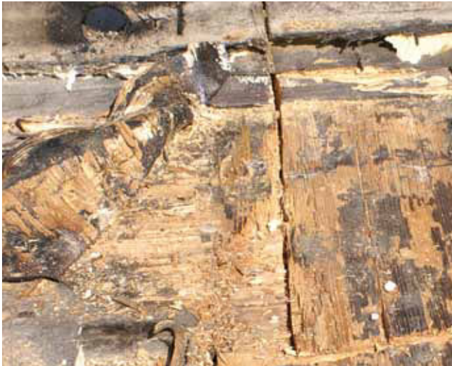
Abb. 3: Schadensbild Sekundärkondensat durch Restfeuchtverlagerung
