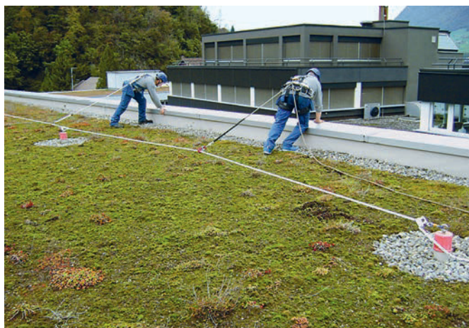
Abb. 10: Temporäres Seilsystem mit Karabinerhaken an EAP befestigt
