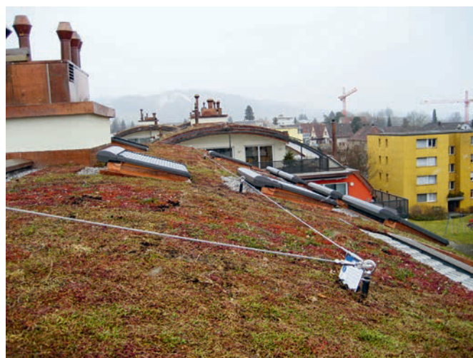
Abb. 6: Ausstattungsstufe 2; Seilsicherungssystem auf begrüntem Tonnendach
