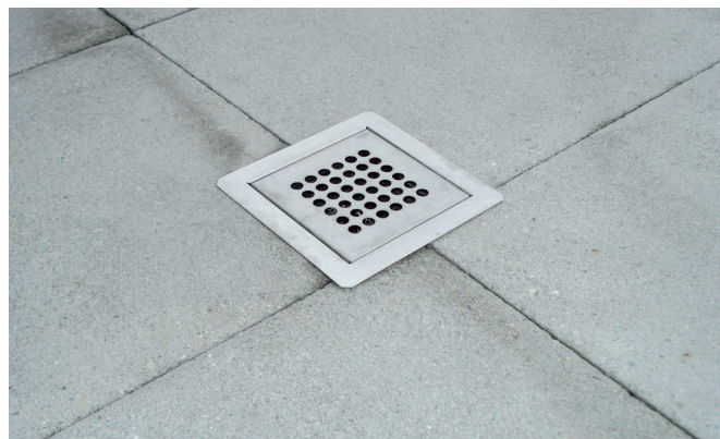
Abb. 17: Dachwassereinlauf: Lochrost
