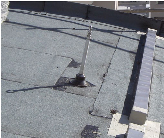
Abb.: Anschlagpunkt für Sicherungssystem
