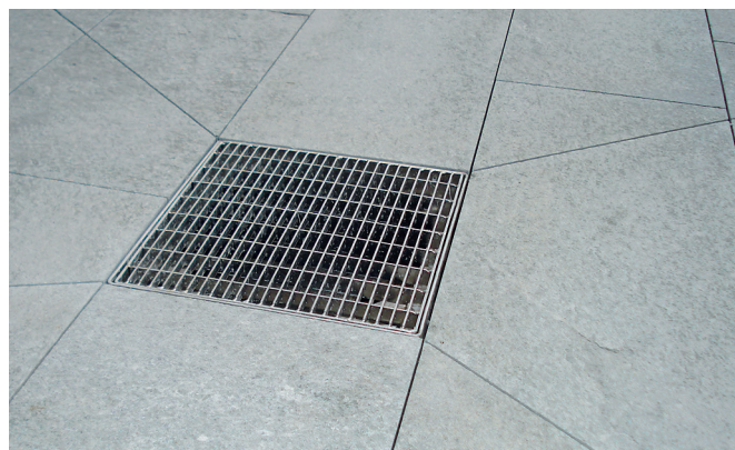
Abb. 16: Dachwassereinlauf: Gitterrost
