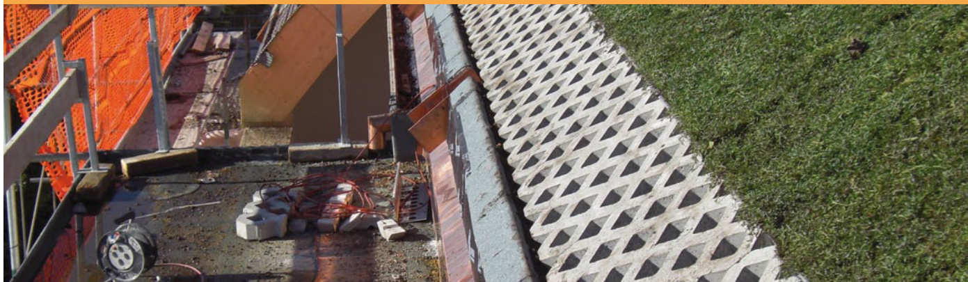
Abb.: Dachaufbau Dachbegrünung, Traufe mit Entwässerung
