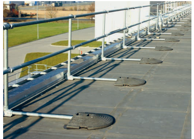
Abb. 16: Ausstattungsstufe 3: Seitenschutzsystem mit Auflast
