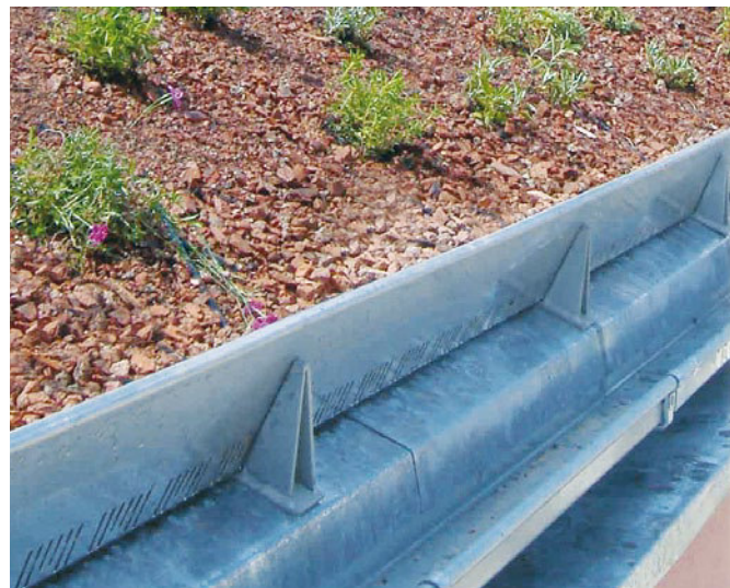
Abb.: Schubsicherung an der Traufe
